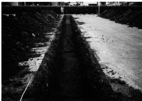
写3 3トレンチB下 北から
