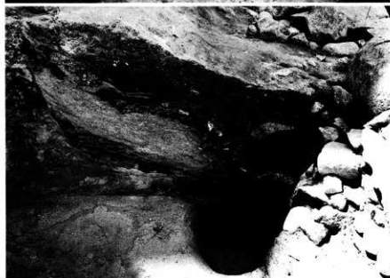
石垣裏込め (北から)
