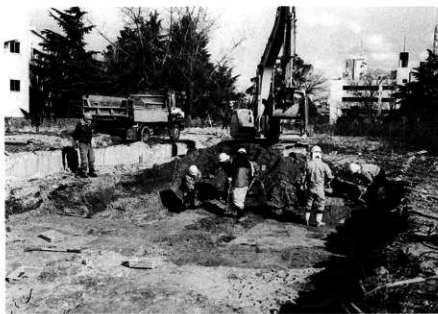
機械掘削時の風景 (西から)
