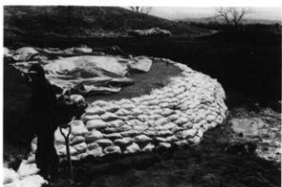
埋め戻し作業（葬石は土壌で養生）
