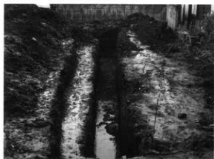
写真11 トレンチ完成状況 南から
