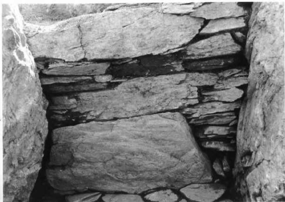
前室左側壁面の正面観
