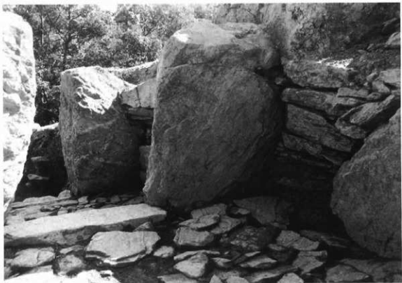
後室、前室の左側壁面を望む
