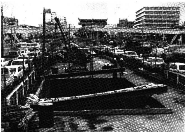
橋脚MP-2 調査区域 (東から)
