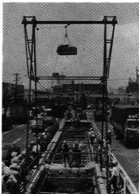
22. 今回の調査のために作製したクレーンによる写真測量
