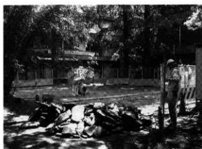
写真1 理学部調査区の作業開始状況
