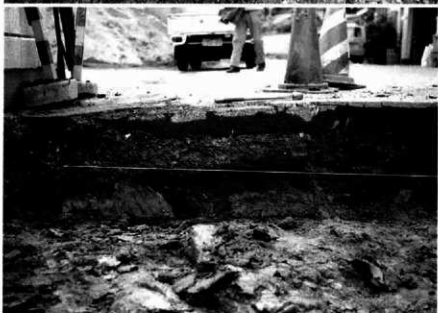
MS84-7次 II・III区間 西壁地層断面(東から)
