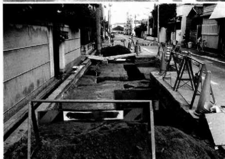
II区全景(西から)
