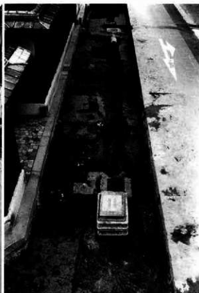
3区南部遺構検出状況(南から)
