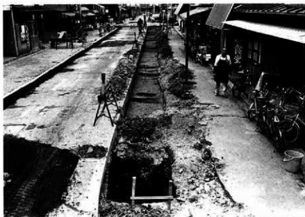
歩道部分調査状況 (西から、手前トレンチ は15地点)
