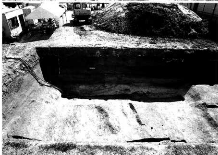
NR301・SD302・ 303検出状況(北から)
