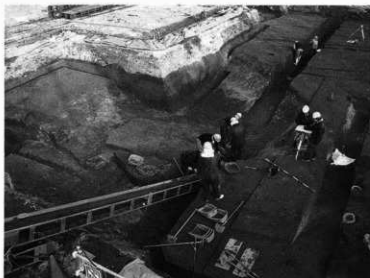
写真1 人力掘削および記録作業
