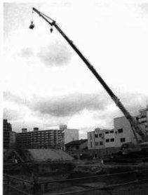
写真2 写真測量の実施状況
