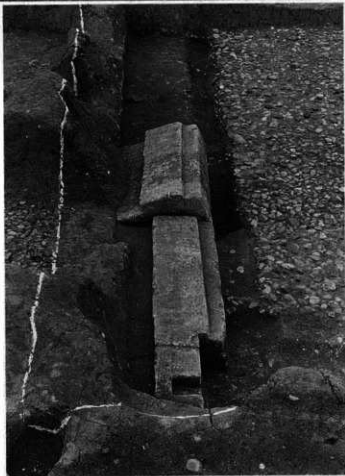
2. 大極殿基壇北面の凝灰岩地覆石(東から)
