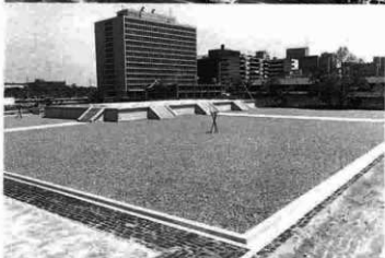
大極殿院復元基壇全景 (南西から)
