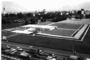
大極殿院復元基壇全景 (北西から)
