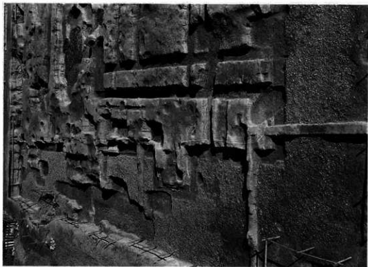
1. 大極殿土壇北側(西から)
