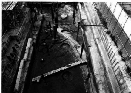
NG90-13次 SD602完掘状況 (南から)
