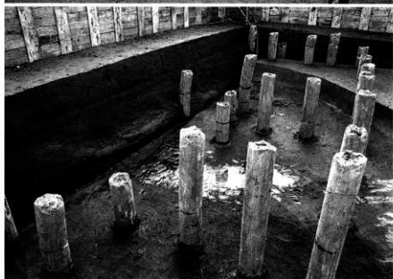
西区NR1001断面 (北東から)
