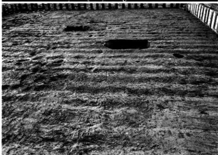
市営住宅建設工事直前 の堀 (東から)
