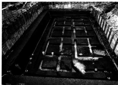
トレンチ配置(南から)
