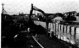
写真2 重機掘削のようす(Ⅰ区)
