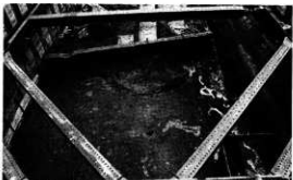
写真3 石器調査のための土留め支保工(Ⅰ区)
