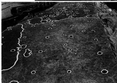
杭列検出状況 (西から)
