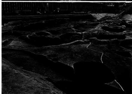
谷頭盛土 (北東から)
