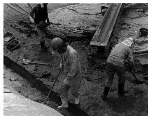
写真2 人力掘削状況
