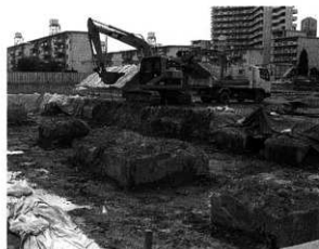
写真1 重機掘削状況
