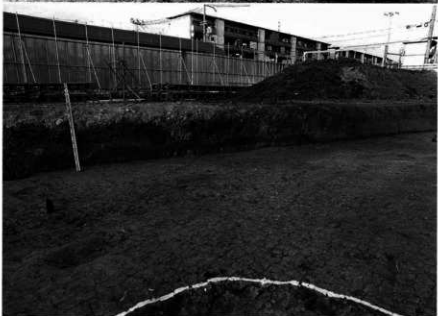
東区北壁断面(南から)
