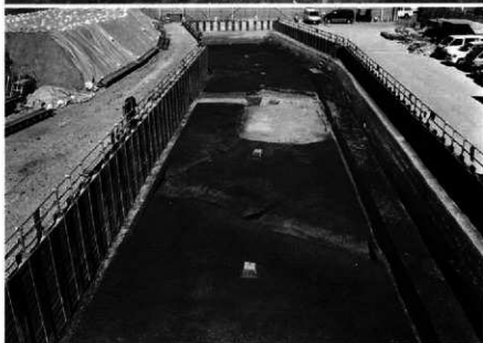
2区 加美6Aiii層上面 遺構検出状況 (西から)
