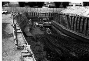
写真2 重機埋戻し風景(1区)
