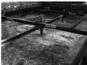
写真4 調査区東部調査前の状況(北西から)
