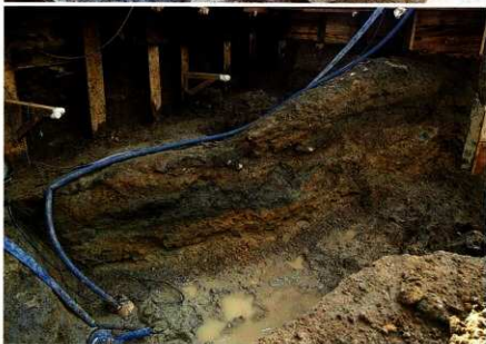
写真5 東トレンチ地層 断面(北西から)
