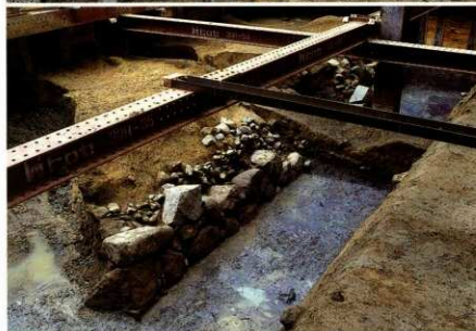
写真8 中央トレンチ西壁の 裏込め状況(南東から)(左下)
