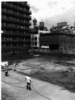
写真1 酷暑の中の散水作業風景
