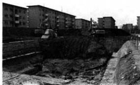
写真4 重機による埋戻し作業のようす(中央区)
