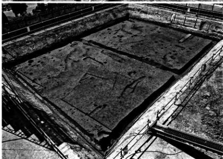
東区 第5B層遺構検出状況 (南東から)
