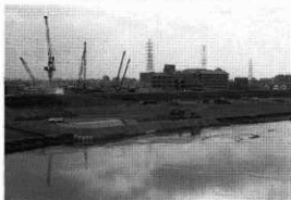
写真2 重機掘削のようす(I区)
