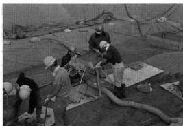
写真3 掘削土の搬出(I区)
