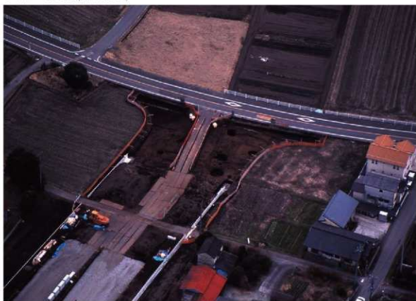
I-2区・I-3区全景(北西上空から)
