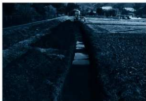
調査区東部トレンチ掘削状況（南から）
