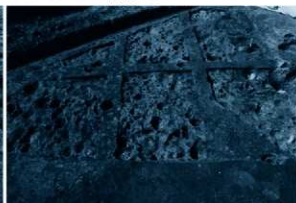
SI-03 床下調査状況 (南東から)
