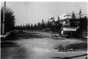
写77 埋め戻し後の状況（南から）
