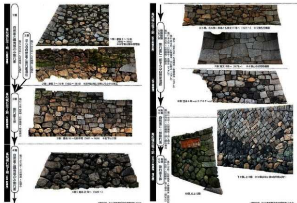
図4 高松城の石垣面変遷図 (拙稿 2023b)
