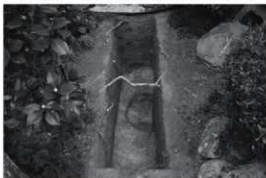
写真17 第2トレンチ完掘状況(北から)
