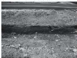
写真8 第4トレンチ完掘状況(南から)
