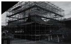
修繕中の鶴林寺護摩堂
