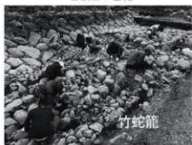
手前の石列は枠の川側に設置された竹蛇籠が
