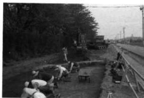
5. 3区表土掘削 (南から)
