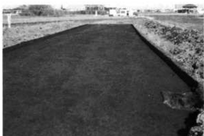
7. 14区全景南半分（南から）
