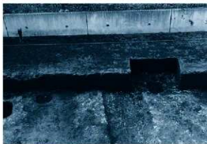
SB-4126全景(南より)
