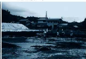
1区作業(水没状況)風景(北より)
