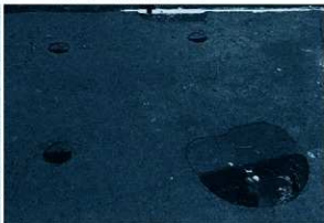
SB-6全景(南西より)
