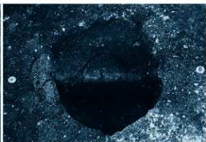
SB-4165東柱列中央柱土層断面(南より)
