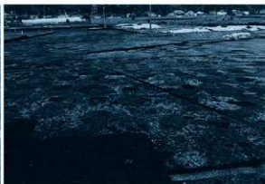
SB-5043・5044A・B期・5045A・B期全景(西より)
