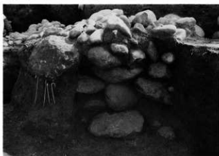
裏込め状況 (北西コーナー)
