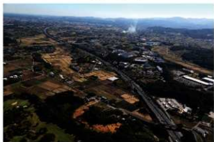
2 遠景（北西から）
