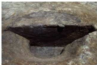
上層 SK13 土層断面 (西から)
