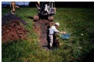
トレンチ 61 の試掘作業（南から）
