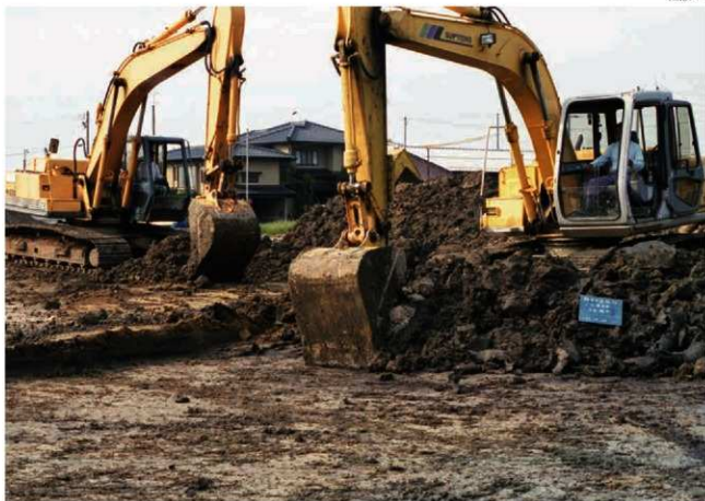
拡張部の重機掘削（南東から）
