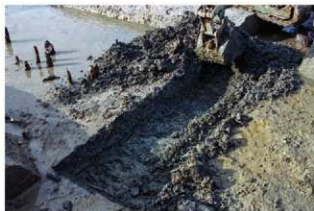
拡張部下層河道の断制作業2（南東から）
