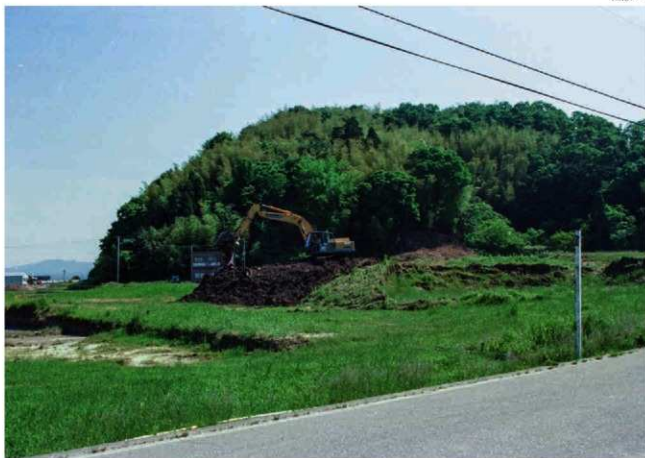
発掘着手前（南西から）
