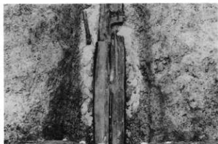
暗渠を取り外し後の木材 東上から
