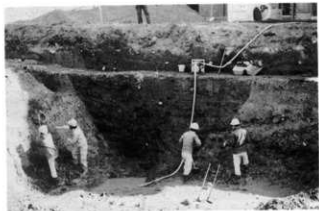
1区1号・3号 発掘作業風景 西から
