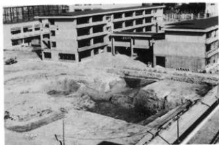
1区全景 たばこ産業倉庫屋上 南西から
