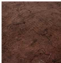
床下コンクリート「ゴザ」痕
