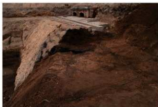
火薬庫からアース線・竪坑までの配線
