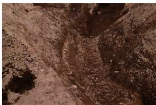
2号溝中で掘り直し箇所
