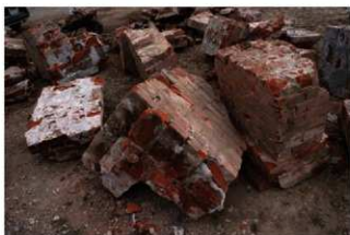
基礎ごと解体（コンクリートが煉瓦を強力に接着）
