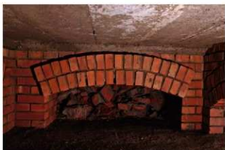
東壁入口内部アーチ・天井板目痕
