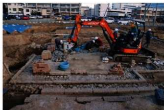
重機でコンクリート砕り
