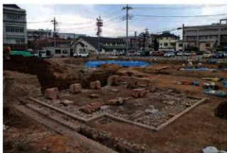
コンクリート砕り建物内外
