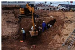
5号井戸 調査状況
