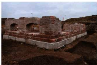
建物外側基礎調査（北東から）
