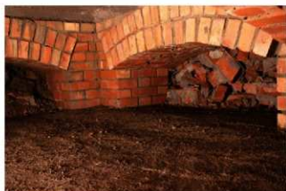
北西コーナー内部
