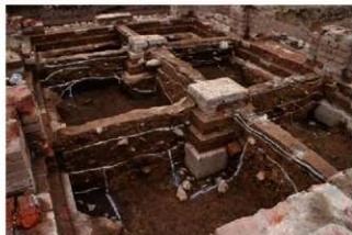
建物内部基礎調査
