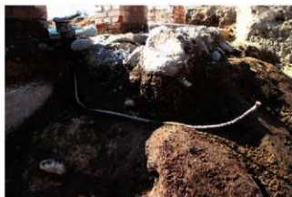
アース線土管を利用した立ち上げ配線
