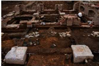
テラス部基礎瓦礫敷込み
