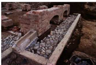
東壁犬走りコンクリート除去下
