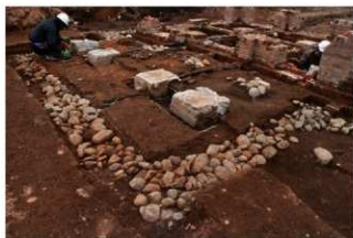
テラス下基礎状況
