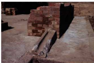
水樋石・縦樋固定金具設置穴
