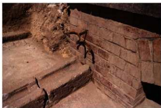
縦樋固定金具と石樋
