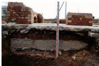
床コンクリート下 基礎確認状況
