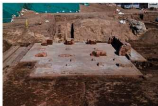
第一火薬庫（南正面入口）
