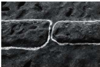
SJ2 水口検出（北から）
