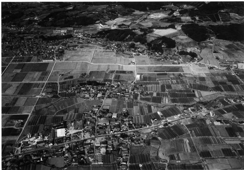
第2図 県営かんがい排水路施行地区（南側より空撮）
