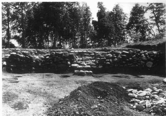
第35図 1号建物石垣と階段
