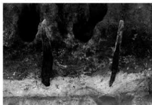
SD-6169 橋脚 (アッブ) ⑤
