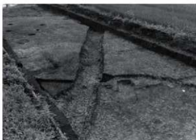
SD-29 完掘状況（南西から）
