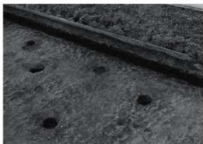
SB-33 完掘状況 (北東から)
