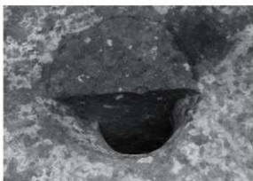
SI-24 P-3 セクション (南から)
