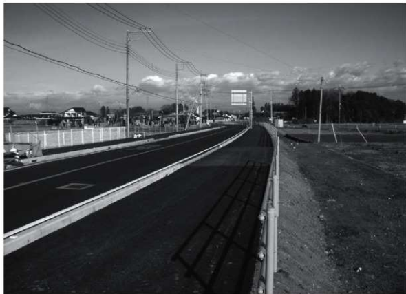
西刑部西原遺跡現況 (南から)
