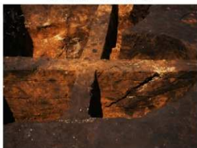
6. SK14 東西セクション (南から)
