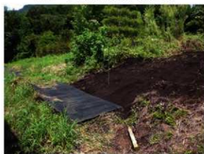
4. 埋戻し状況（南東から）
