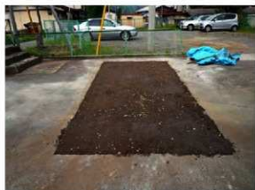
1. 埋戻し状況（西から）
