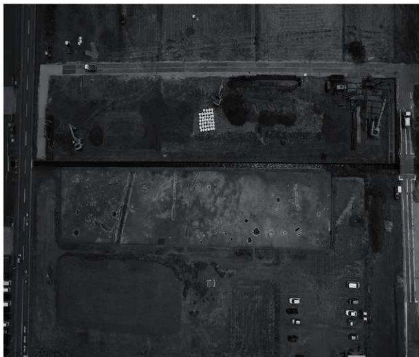
調査区全景 俯瞰
