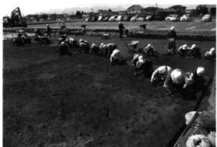
作業風景 (南東から)
