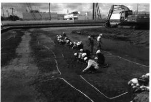
作業風景 (北から)
