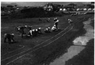
作業風景 (南東から)
