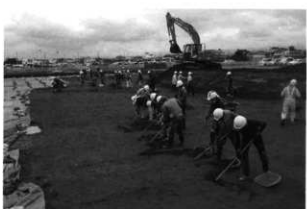
作業風景 (東から)
