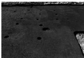
2区 SB-121(奥)・122(手前) (東から)
