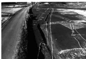
SG1 区 SA-103-S-129-SD-95 (南から)
