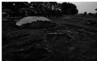
〔7〕調査区中央部終了状況 (西から)
