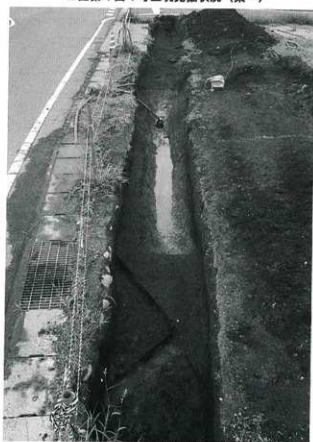
B区第2面完掘状況全景(北→)
